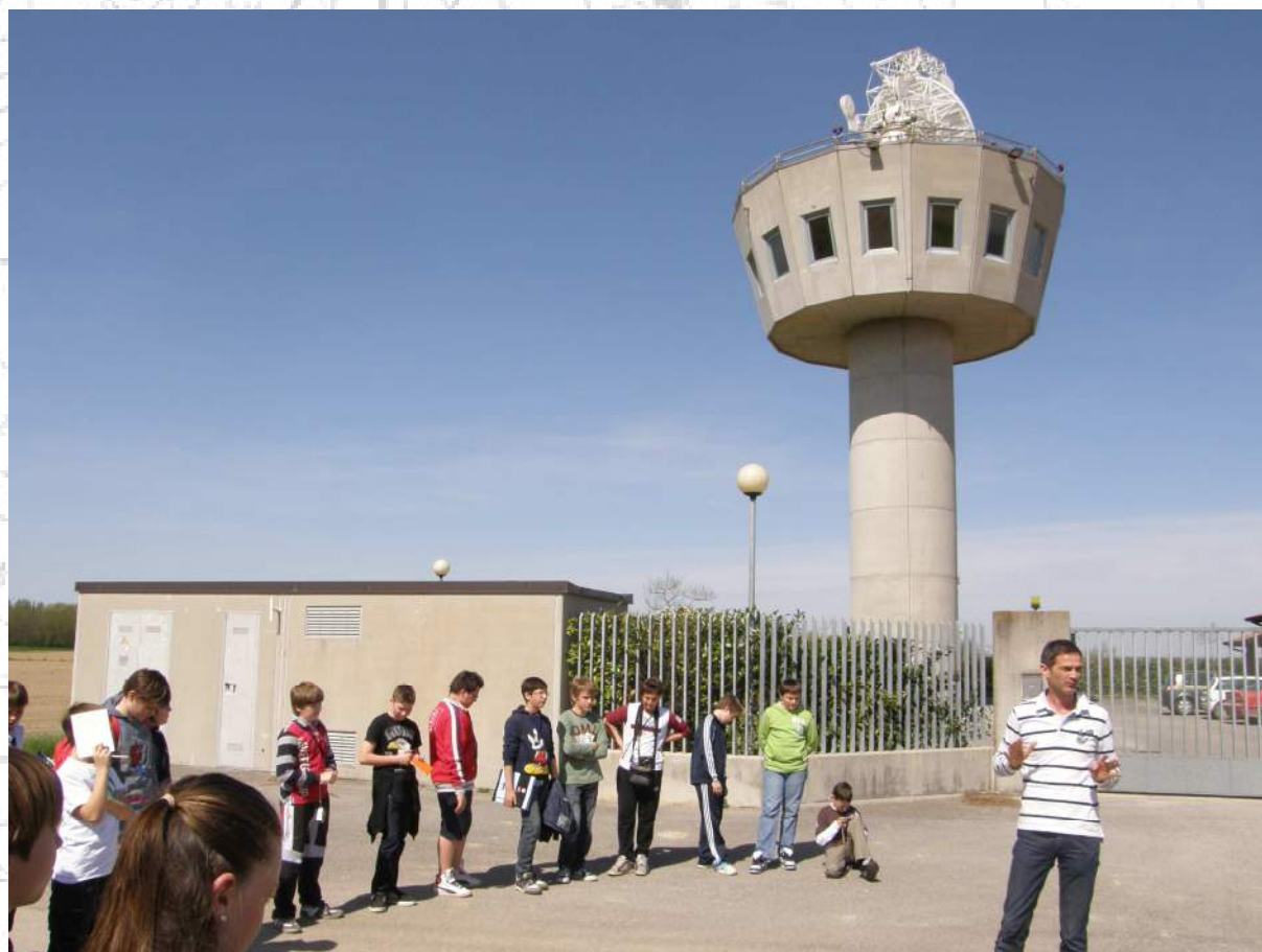
Radar meteorologico di Fossalon di Grado
